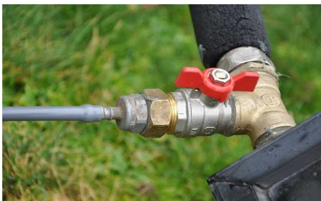
Un purgeur automatique, monté sur une vanne quart de tour, est placé au point le plus haut, ce juste avant l'échangeur du cumulus solaire.
