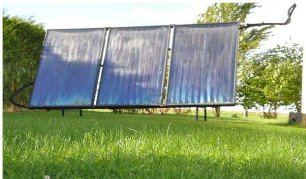
Au delà de 3 capteurs, ils doivent être raccordés en boucle de Tickelmann :
